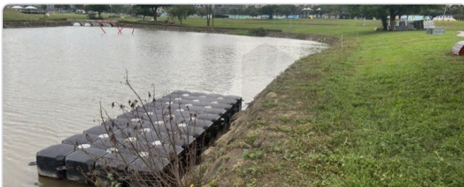
浮台架設於水面·浮台完工 · 2025
